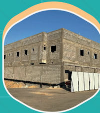
مشروع اكمال البناء
