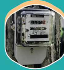
مشروع سداد فواتير الكهرباء
